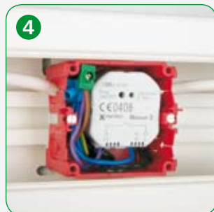
Zabudowa odbiornika w puszce koryta kablowego
